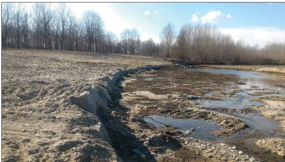
Figura 7.8 – Difesa spondale ripristinata utilizzando i massi della scogliera precedente riportando a tergo materiale prelevato dall'alveo.
